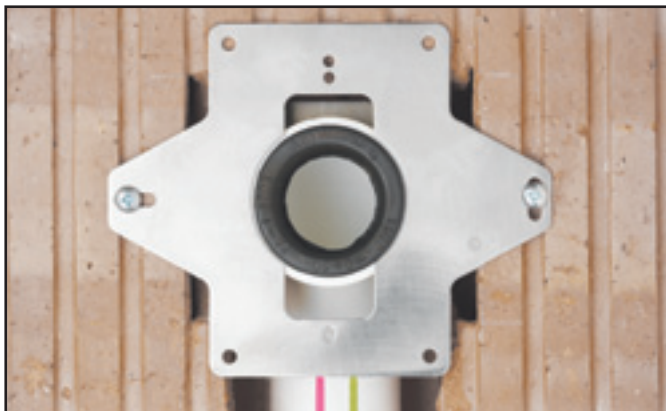
Рис. 6-2: Смонтированная монтажная рамка
