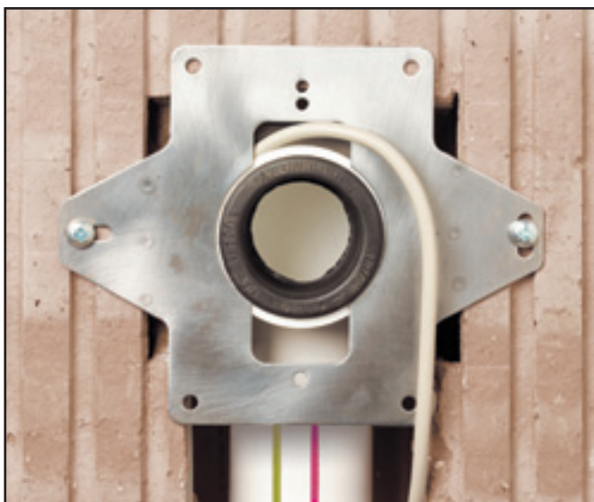
Рис. 6-35: Установленная монтажная рамка и кабель управления
