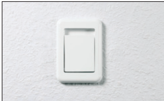
Рис. 6-37: Полностью смонтированная всасывающая розетка
